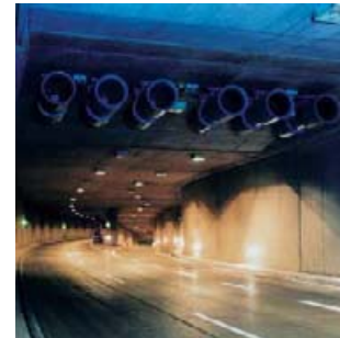
Túnel de circulación
